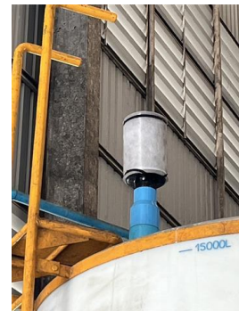
ภาพที่ 2.2-6 ระบบดูดซับโอโรเซเหยถ่านกัมมันต์ (Activated Carbon Filter)
