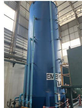
ภาพที่ 2.2-4 ถังพักน้ำทิ้งลูกเดิน
